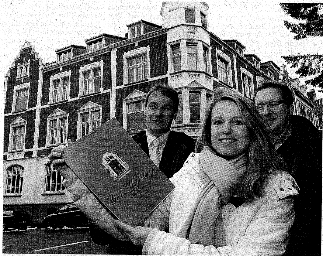
Dr. Astrid Rieke und ihr Mann Heinz Johannes (l.) freuen sich mit Makler Olaf Jansen über den Erwerb des Baudenkmals. Seit 1987 steht das ehemalige Kontorgebäude mit seiner Fassade im Historismus-Stil unter Denkmalschutz. Foto: Uli Preuss
